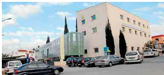
Imagen de las instalaciones de Acosol en Marbella. JOSELE
